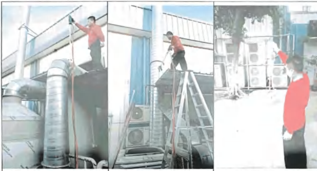
有组织废气 1#注塑工序废气处理前
