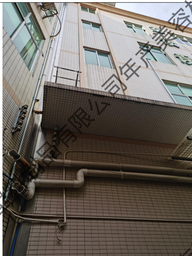
项目西侧厂房
