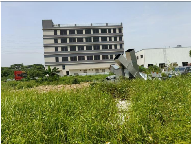
项目西南面-空地、新建厂房（广州市保为康劳保用品有限公司）
