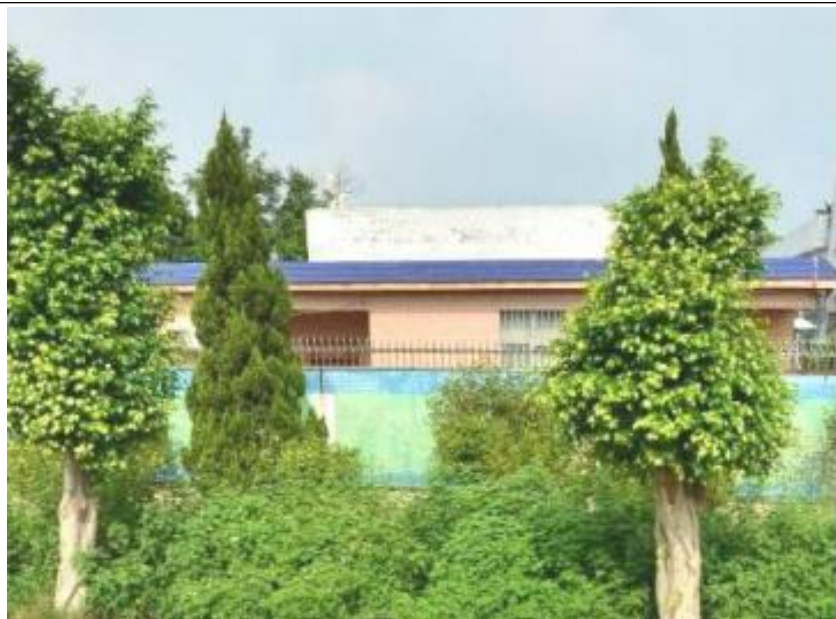
项目东北侧五金厂房
