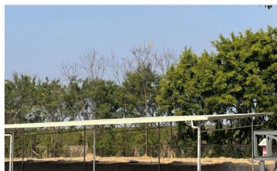
东面与联合排洪渠间的坝
