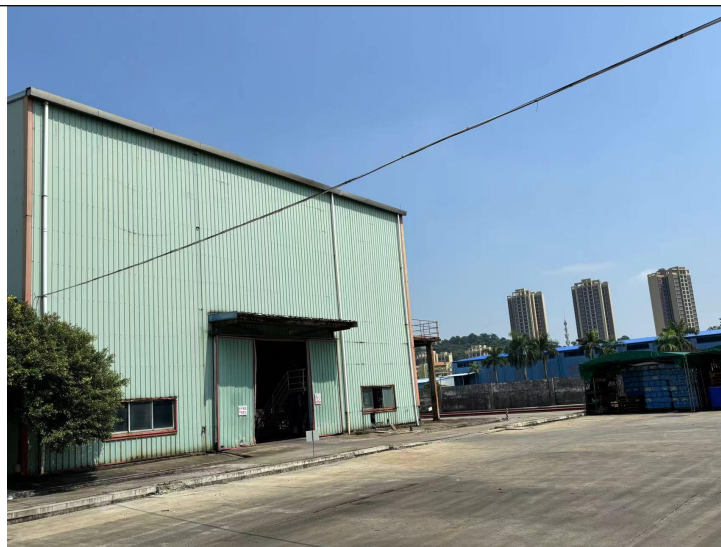
项目生产车间
