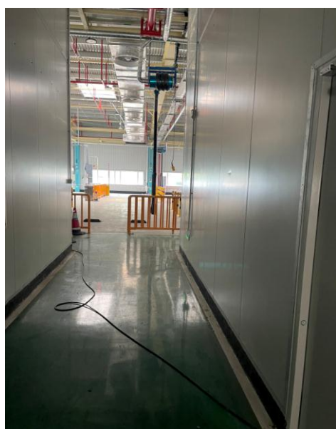
射线设备室南侧过道
