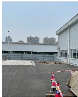
品保评价场东侧室外道路
