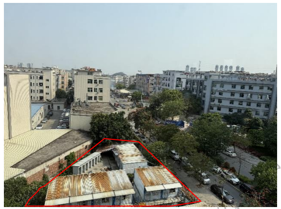
南面：园区临时施工营地
