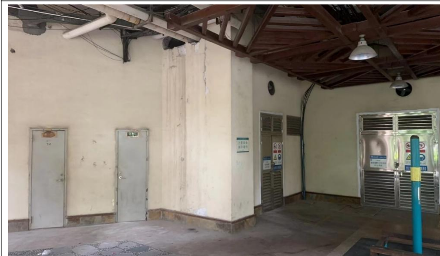
项目西面：小区机房
