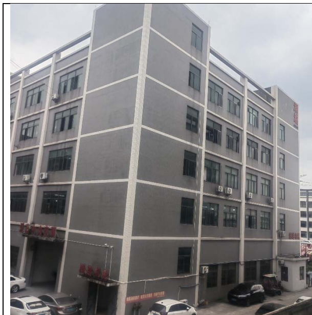
项目东面广州潮越机械设备有限公司
