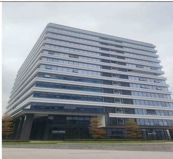
南面：园区 D2 栋厂房
