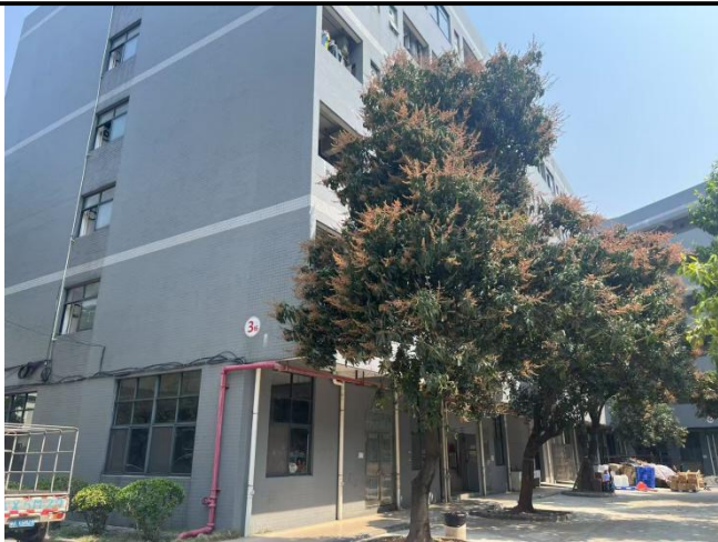
项目东北面：园区 3 座
