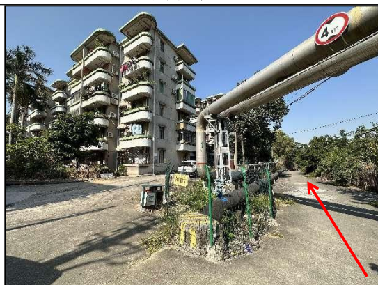
沿晨光路向北敷设
