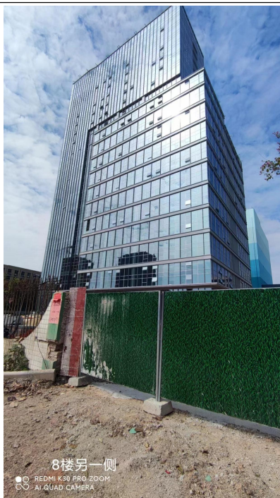
项目西南面的厂房
