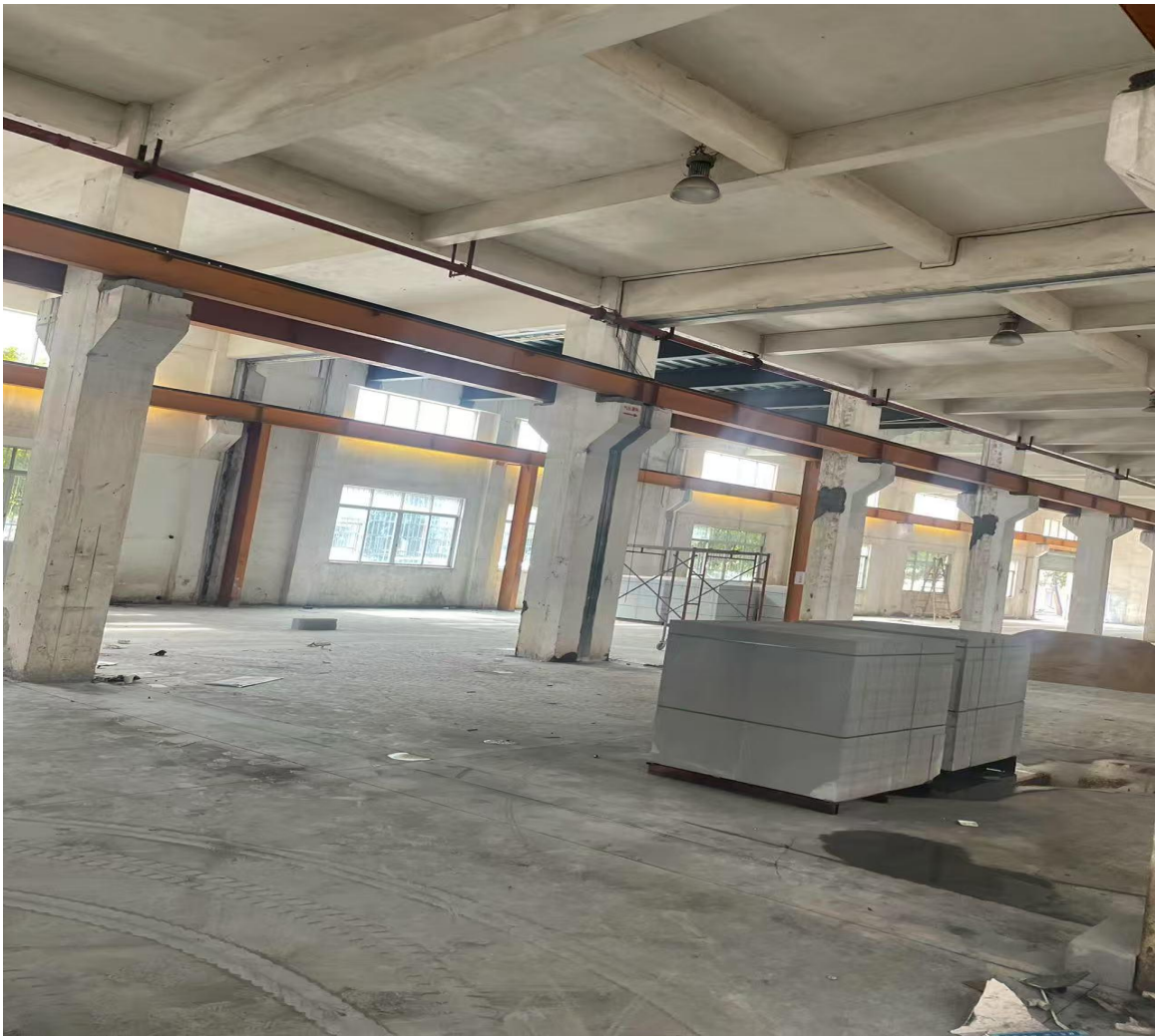
图3-1 项目厂房现状地面硬化情况照片图
