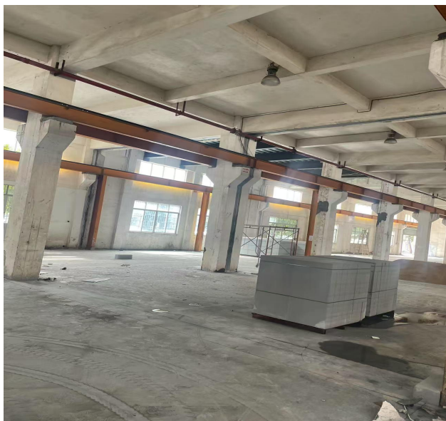
项目厂房内部现状
