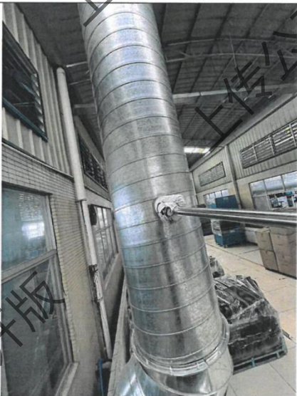
图 9.3 生产车间废气处理后检测口◎Q2
