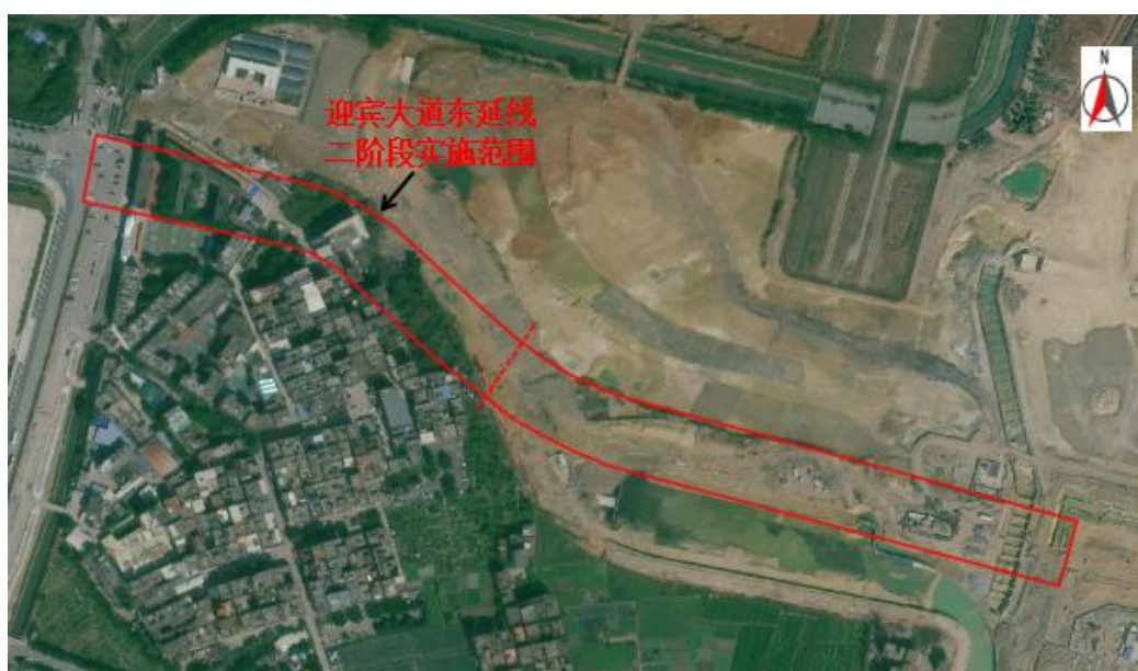
图 2-2 本项目二阶段实施建成后情况
