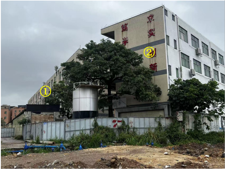
教学楼①及②面向近期接驳线一侧
