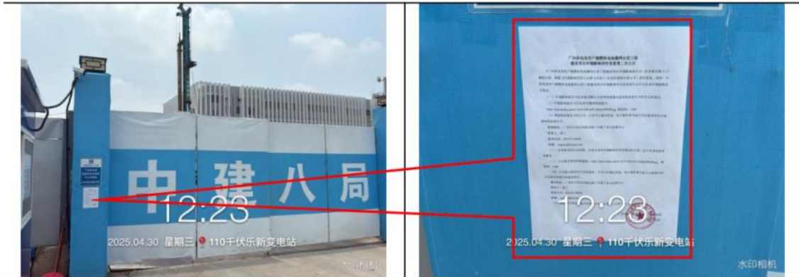
110 千伏乐新变电站（在建）（远照）
