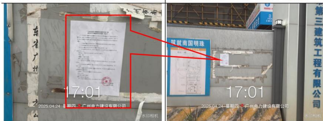
广州电力建设有限公司（在建）（近照）
