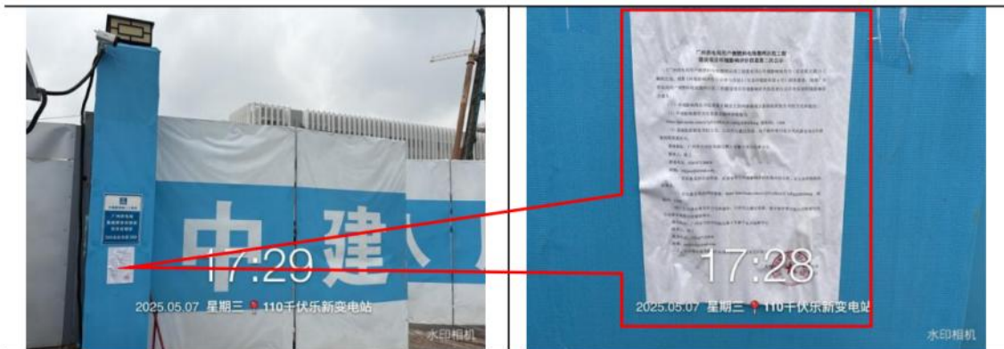
110 千伏乐新变电站（在建）（远照）
