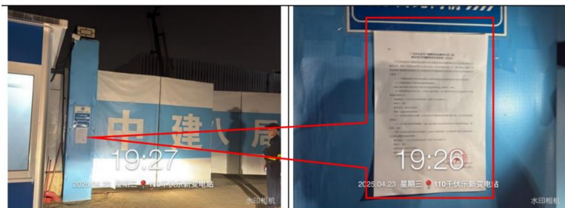
110 千伏乐新变电站（在建）（远照）
