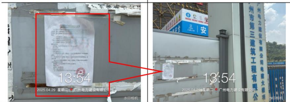
广州电力建设有限公司（在建）（近照）
