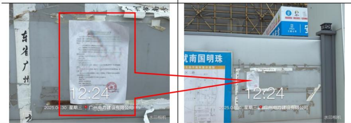
广州电力建设有限公司（在建）（近照）
