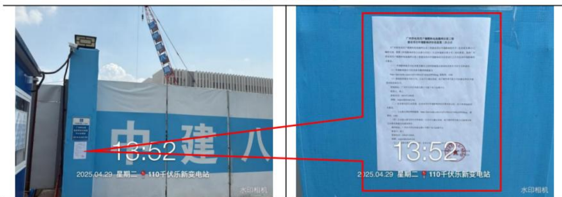
110 千伏乐新变电站（在建）（远照）
