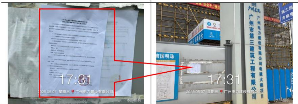
广州电力建设有限公司（在建）（近照）
