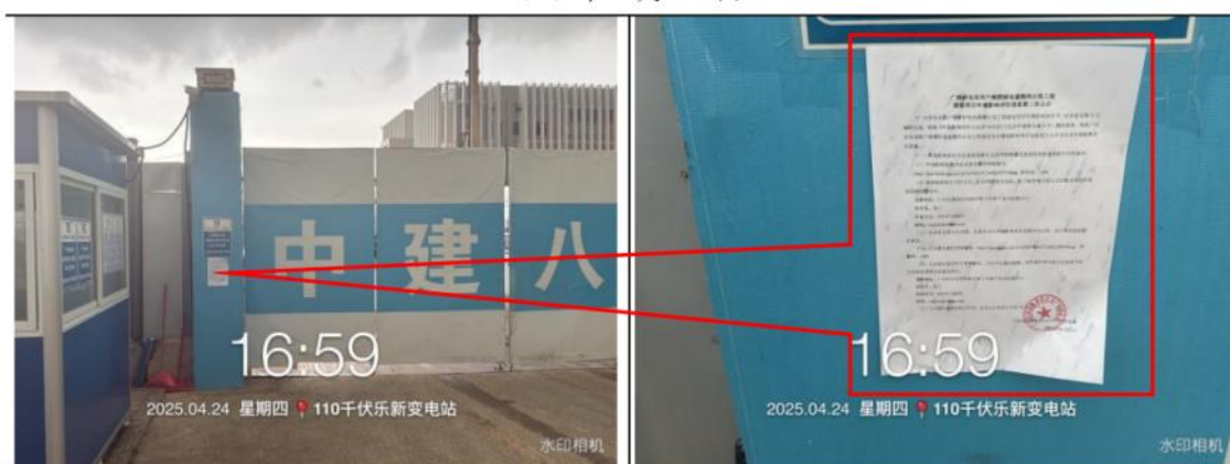
110 千伏乐新变电站（在建）（远照）
