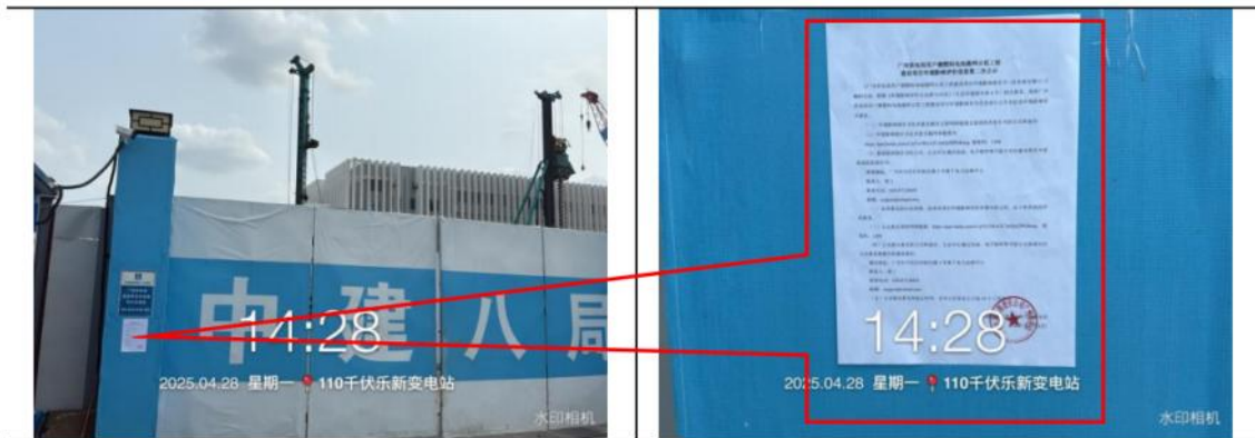
110 千伏乐新变电站（在建）（远照）
