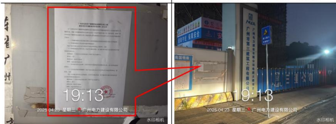
广州电力建设有限公司（在建）（近照）
