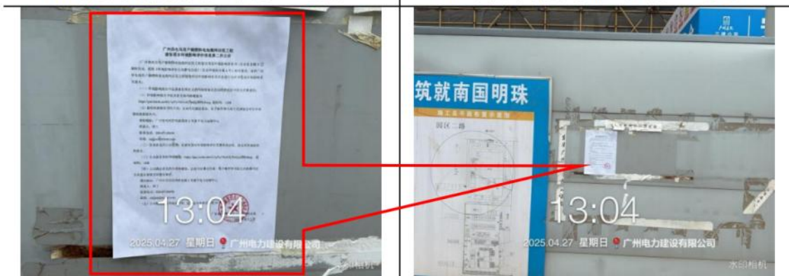
广州电力建设有限公司（在建）（近照）
