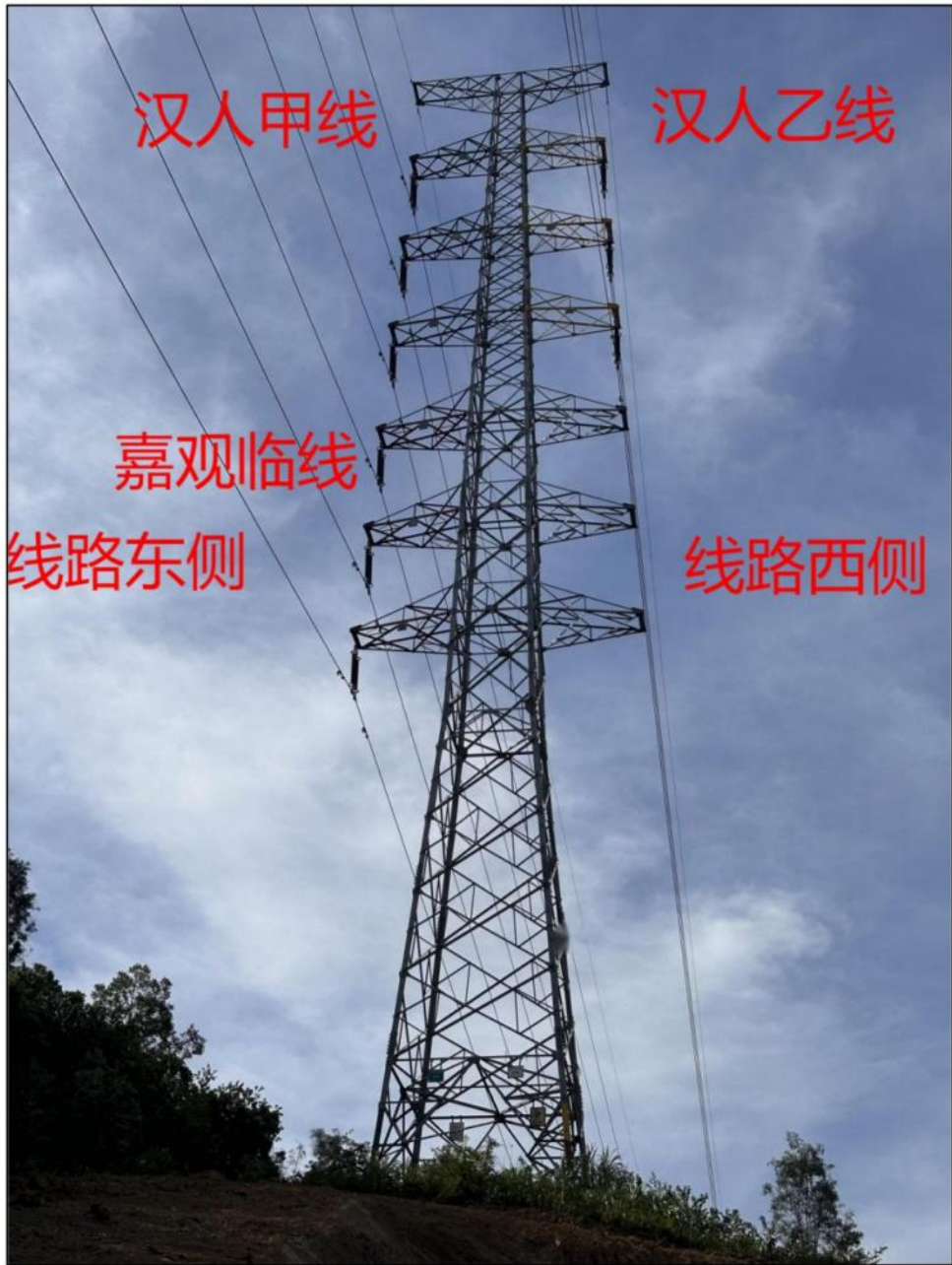
图 5.1-1 现有线路挂线布置示意图
