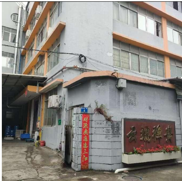
项目西南面-广州云端汽车弹簧有限公司
