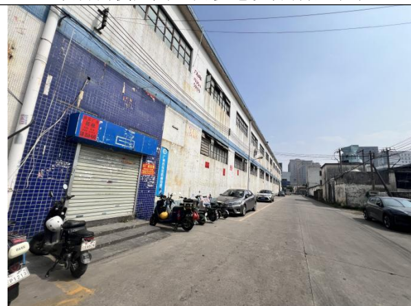
西北侧原广州市钛沧机械有限公司
