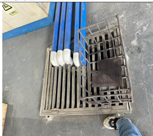
循环冷却水池
