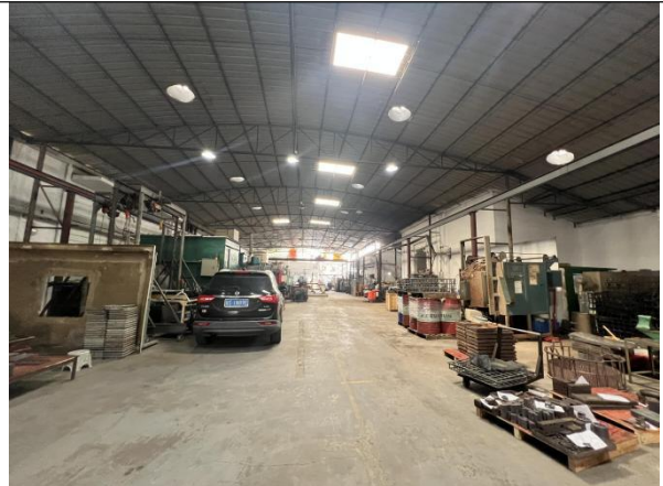
项目车间现状（西侧）
