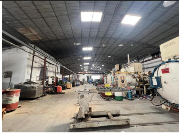
项目车间现状（东侧）
