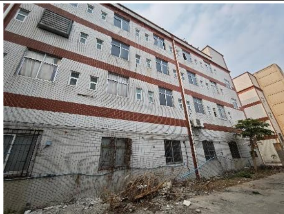
项目北侧其他工业厂房
