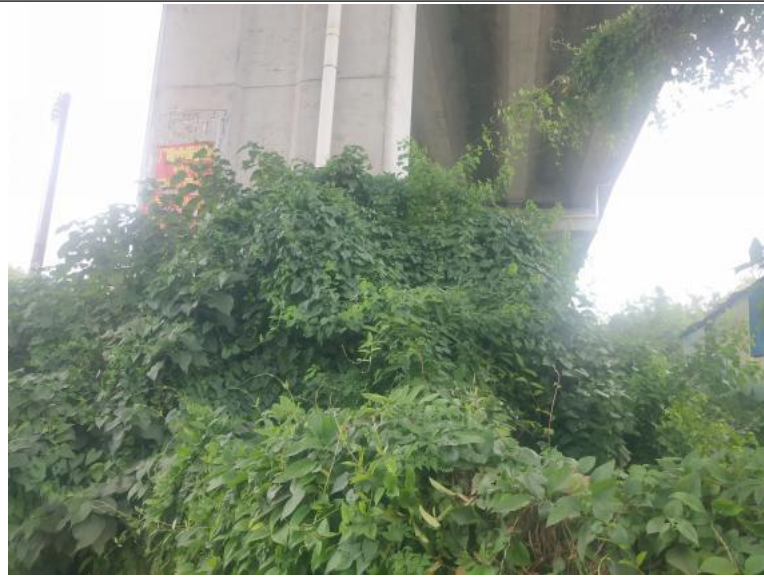
项目东南面：珠三角环线高速
