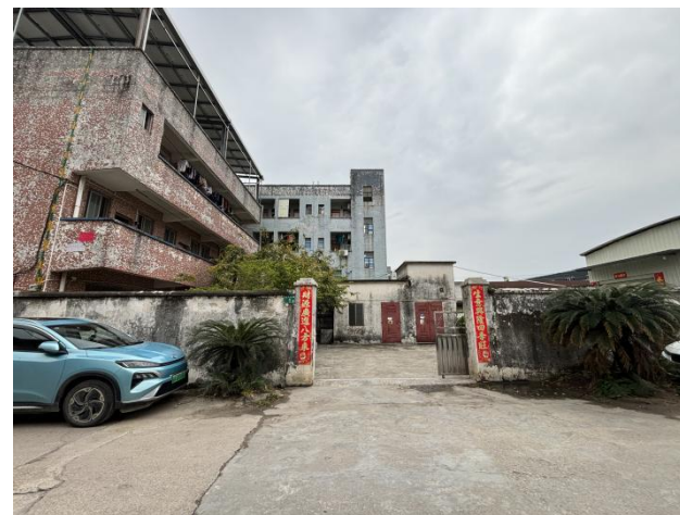
项目西面：其他公司宿舍楼
