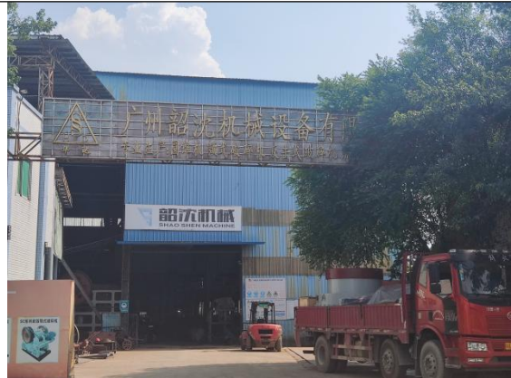
南面：广州韶沈机械设备有限公司
