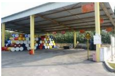
危险废物存放场
