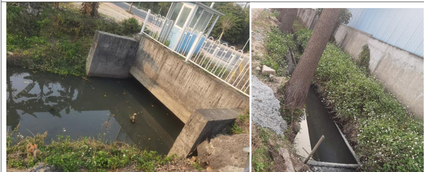
杨村圳河河道整治工程现状 附图 12 项目现场照片
