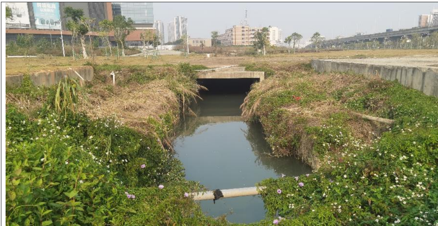
平步大道以北截洪渠、截洪箱涵工程现状
