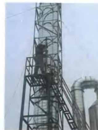
熔铝、脱模、压铸废气处理后 采样口 G3
