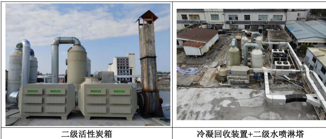
图 4-5 废气处理工程照片
