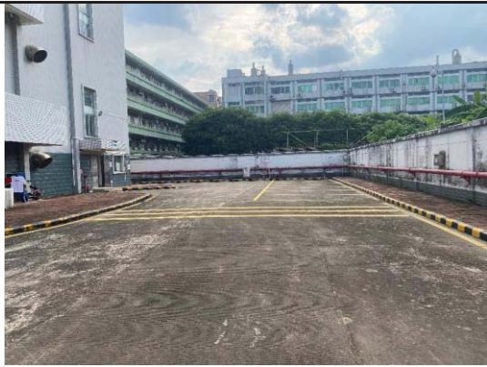
站内道路及地面硬化
