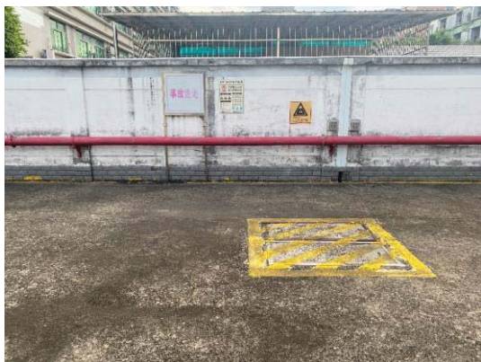
前期已建设事故油池
