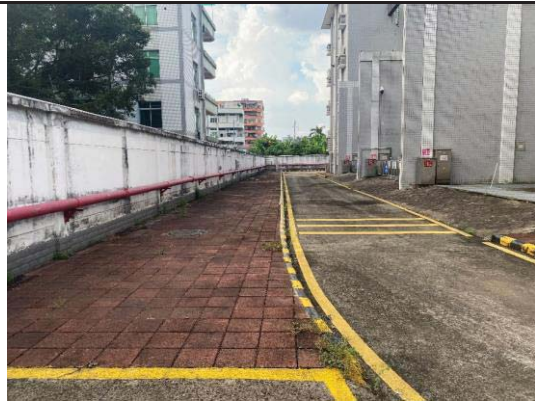
站内道路及地面硬化
