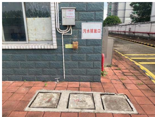
前期已建设化粪池
