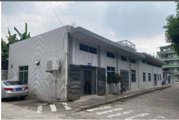
市桥金银珠宝加工工业区安全管理办公室
