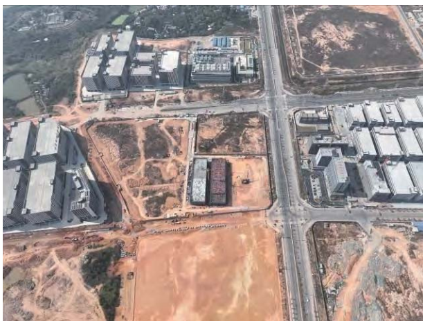
项目地块西侧-在建厂房
