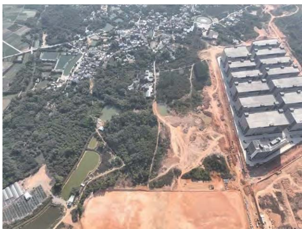
项目地块南侧-待平整地
