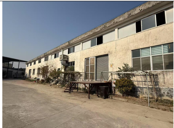
项目所在厂房外部
