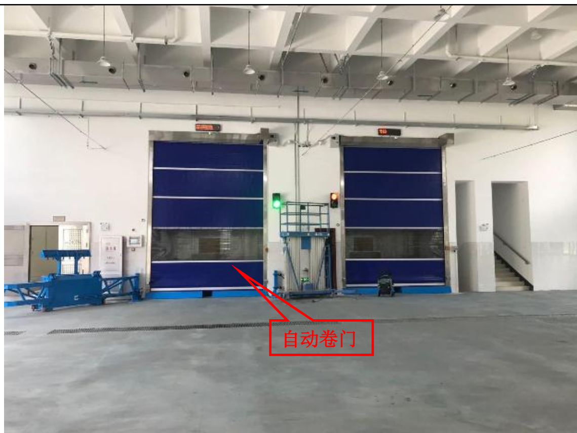
图 4-5 卸料口自动卷门参照图
