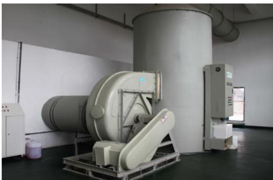
图 4-9 负压抽风除臭系统参照图
