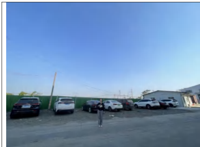
项目东北面：工业道路及停车场
