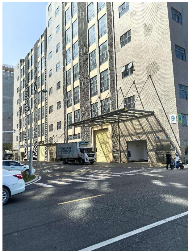
项目西北侧厂房
