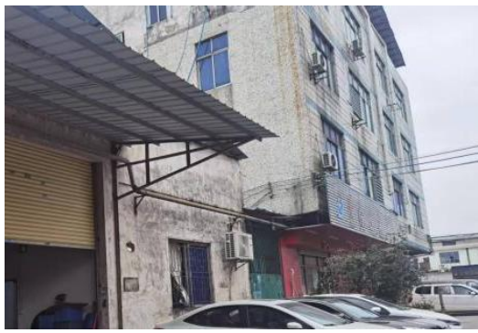
项目北面-工业厂房
