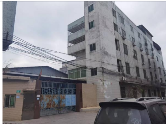
项目东南面-广州霖端家具厂
