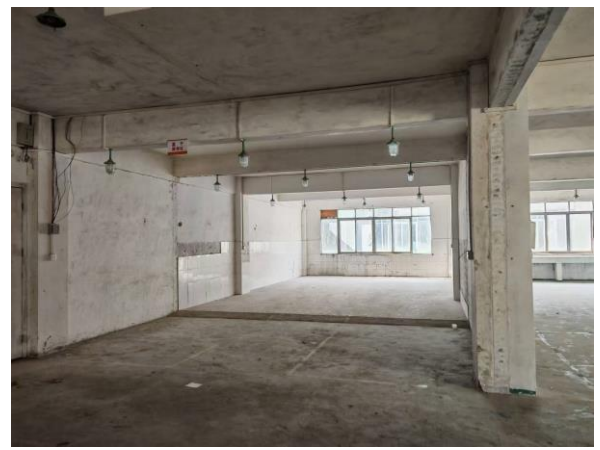
项目空厂房照片
