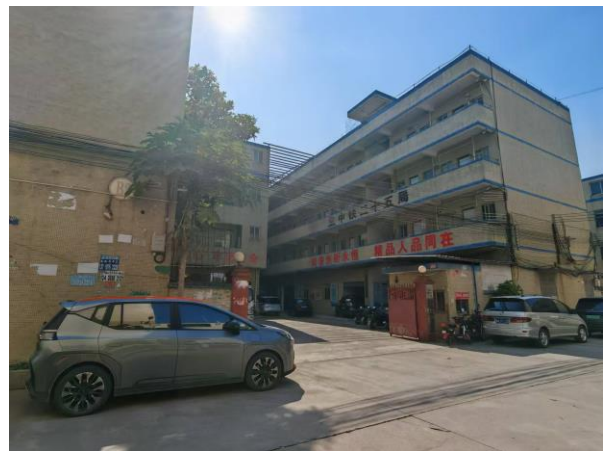
项目西面-中铁二十五局项目部
