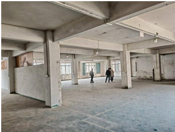
项目空厂房照片
