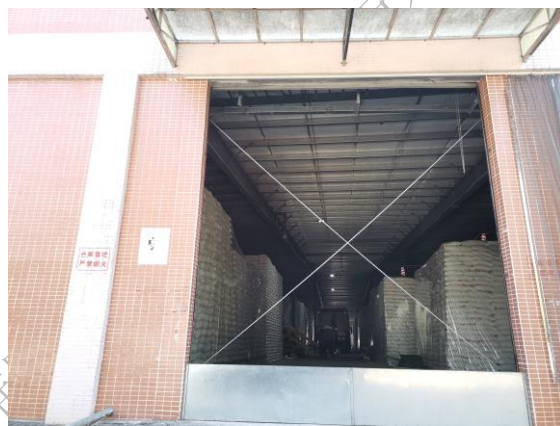
北面：万瑞通电缆实业有限公司仓库
