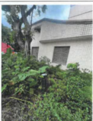
项目南厂界外1米处N2
