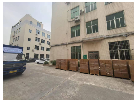
北面-园区办公楼
