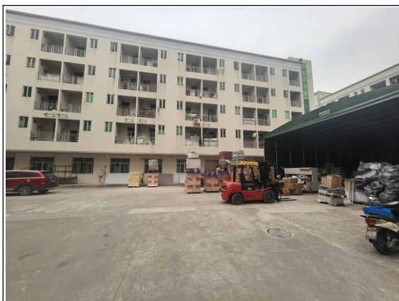
东面-园区宿舍楼
