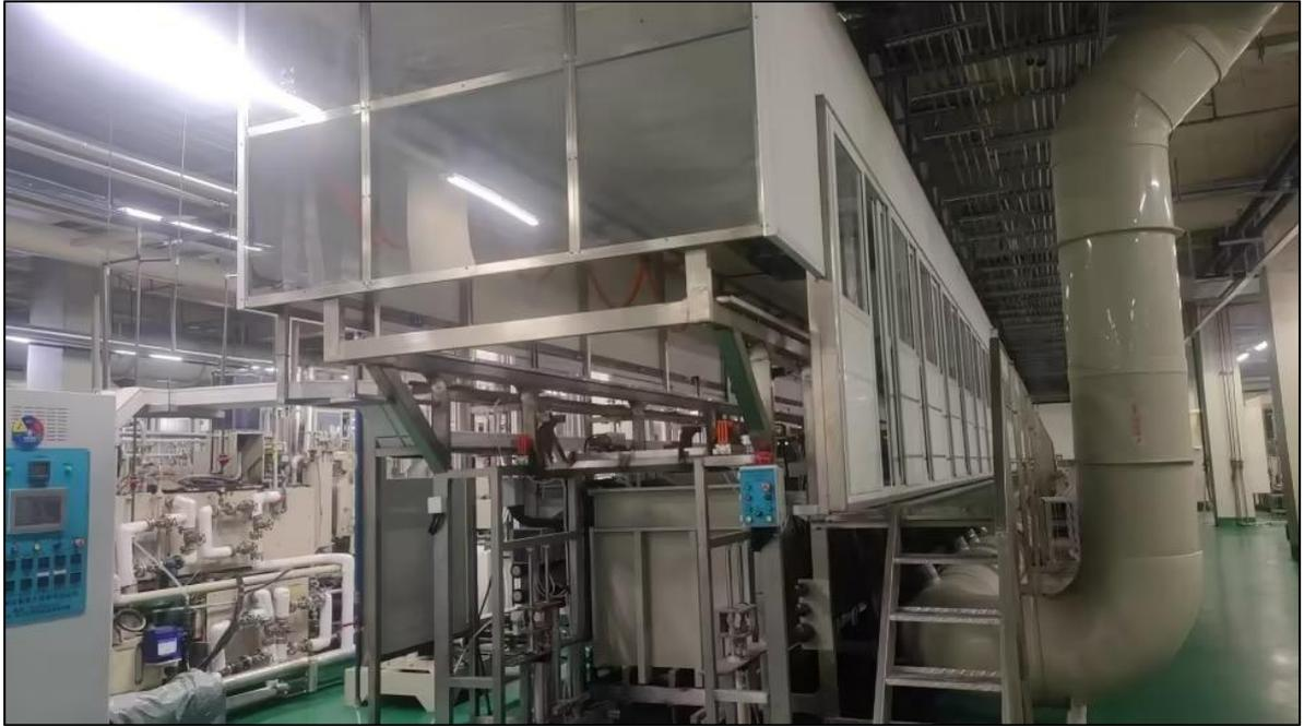
图 1.8-2 垂直线废气收集设施示意图
