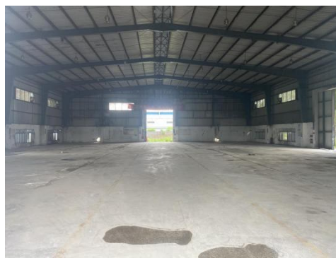
甲类车间设备拆除
