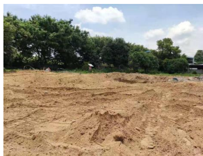
埋地罐区拆除
