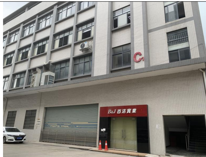
项目北面：园区 C1 栋厂房
