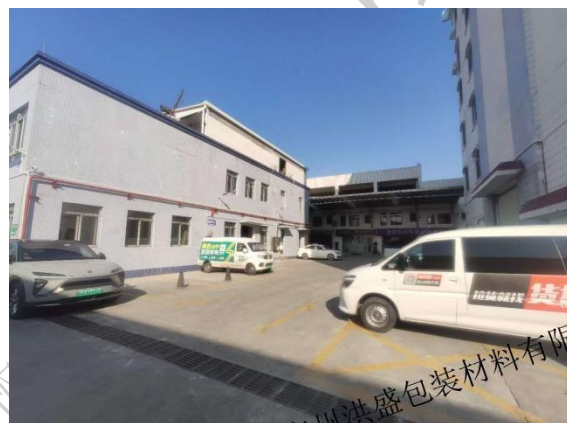
项目西侧--空厂房
