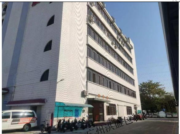
厂房正面（租用 1-3 楼）
