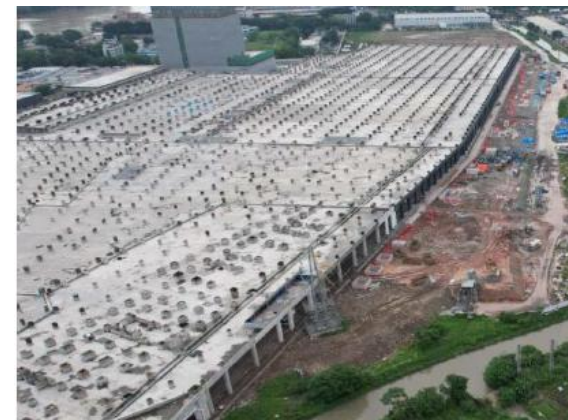
在建地铁十二号线车辆段用地
