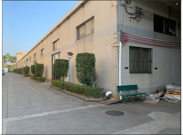
南面-广州市霏鸿机电科技有限公司
