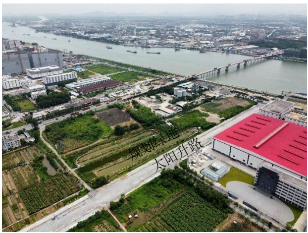
项目东南侧现状照片
