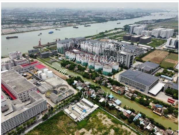
项目西北侧现状照片
