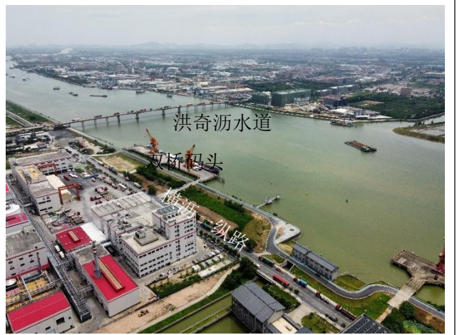
项目西南侧现状照片
