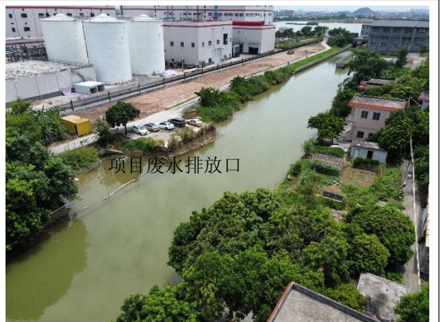
项目废水排放口现状照片
