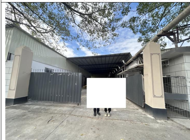
项目厂区大门
