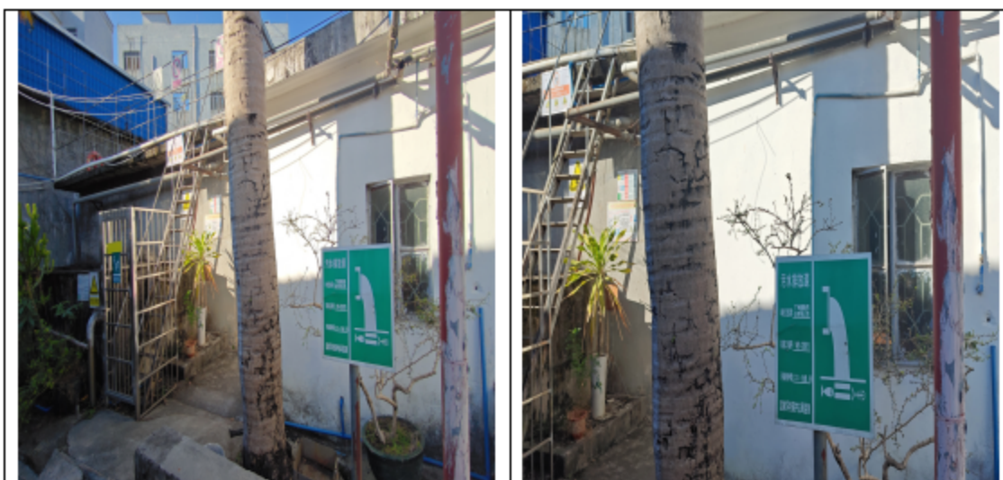
自建污水处理站污水排放口 WS-12001
