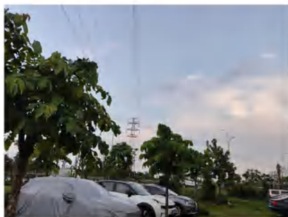
110kV 郭车甲乙线换线段
