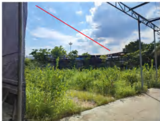
500kV 北花甲乙线新建段
