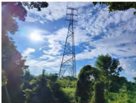
500kV 北花甲乙线换线段
