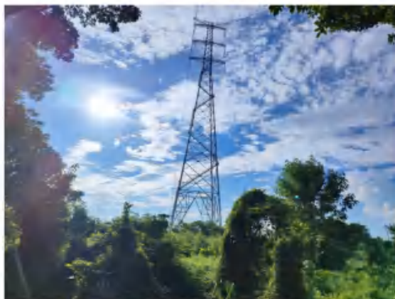
500kV 北花甲乙线换线段
