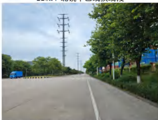
220kV 炭车甲乙线换线段
