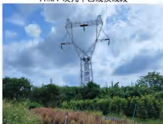
110kV 炭白线换线段
