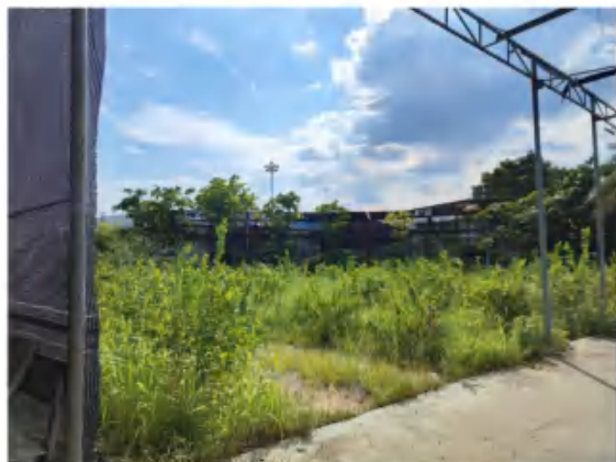
500kV 北花甲乙线新建段
