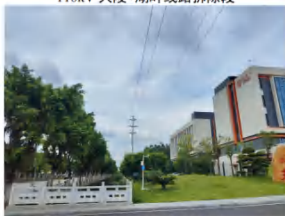
110kV 炭九甲乙线换线段
