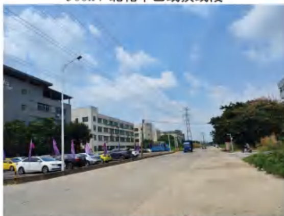
220kV 北镜甲乙线换线段
