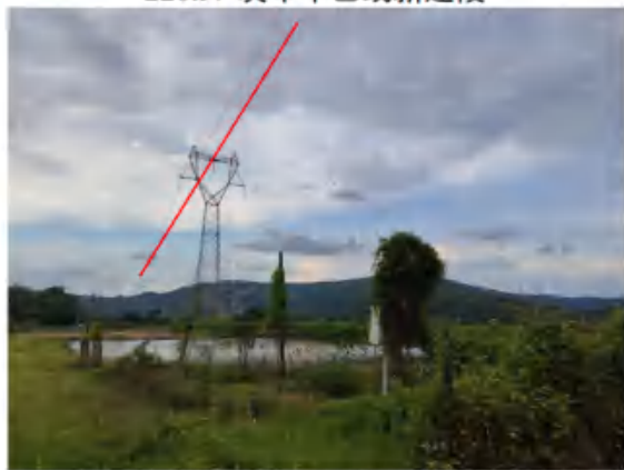
220kV 朗郭线新建段
