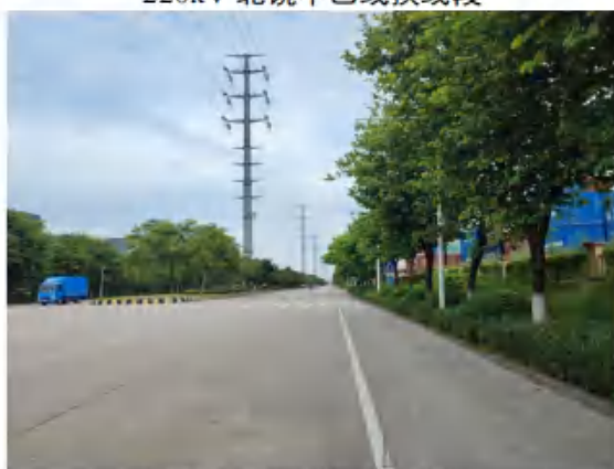
220kV 炭车甲乙线换线段
