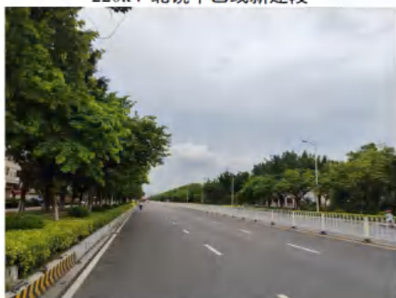
220kV 炭车甲乙线新建段
