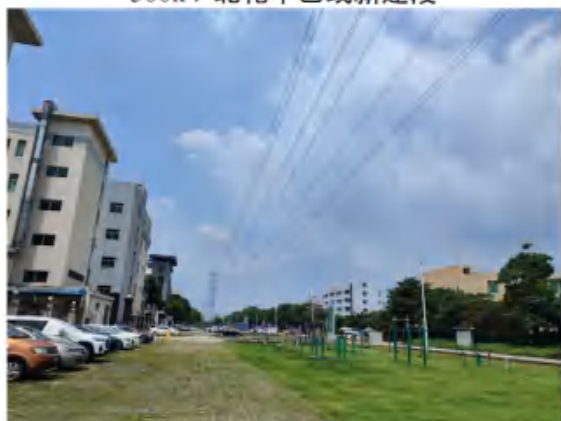
220kV 北镜甲乙线新建段
