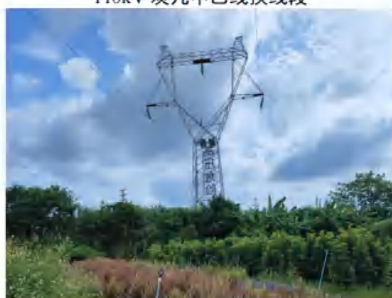
110kV 炭白线换线段
