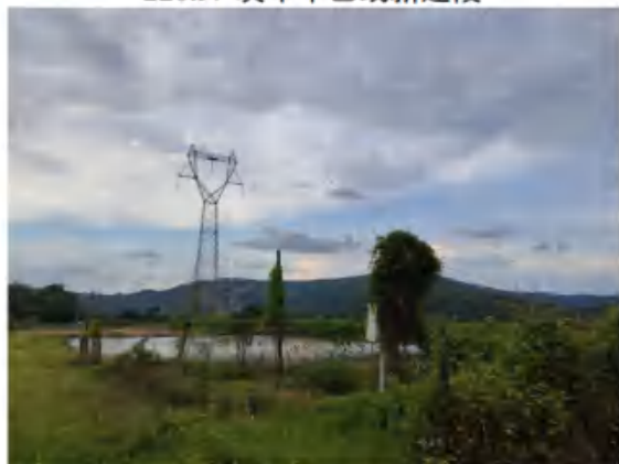
220kV 朗郭线新建段
