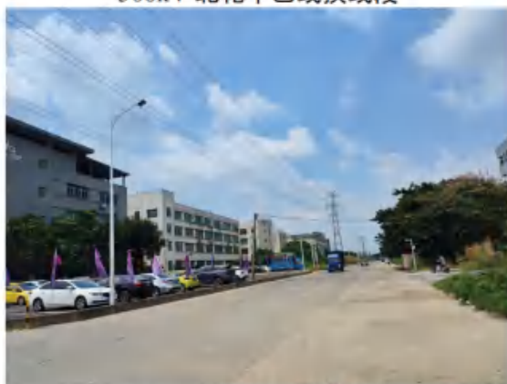
220kV 北镜甲乙线换线段
