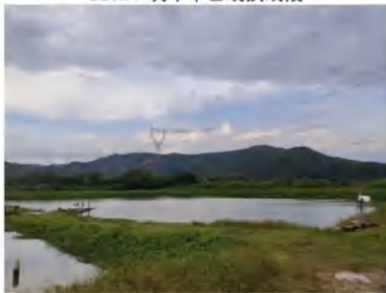
220kV 朗郭线换线段
