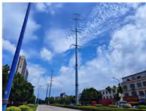
110kV 大陵~湖畔线路拆除段
