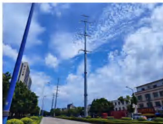
110kV 大陵~湖畔线路拆除段
