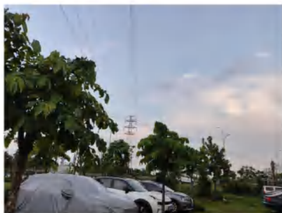
110kV 郭车甲乙线换线段
