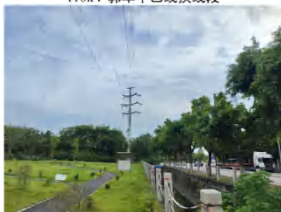
110kV 炭九甲乙线新建段
